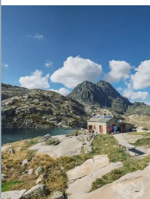
Refuge d'Arrémoulit, avant travaux. © Jan Novak - Collection FFCAM
