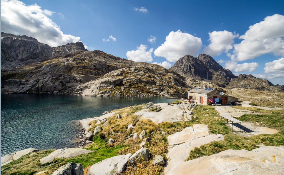
Refuge d'Arrémoulit avant travaux © Jan Novak - Collection FFCAM
